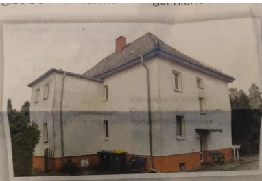
Seit mehr als drei Wochen frieren die Mieter in diesem Haus in der Windmühlenstraße in Elsterwerda. Es sind ältere Menschen.
